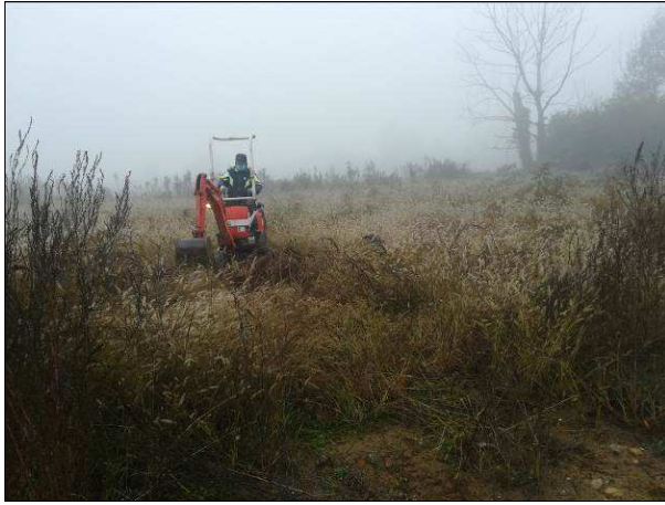
Preparazione area indagine.
